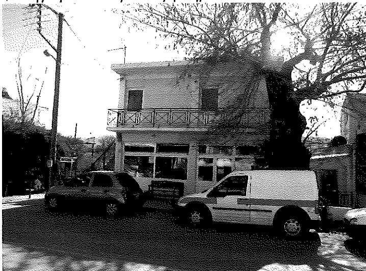
Φωτογραφία 14 : βορειοανατολική όψη κτηρίου
