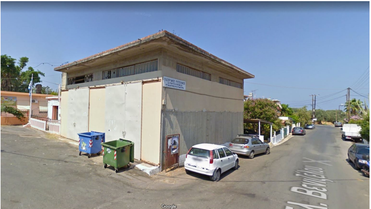
Το κτήριο του συνεταιρισμού (αρχική κατάσταση)
