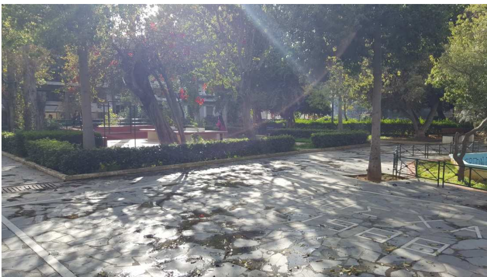
Φ06 Η πλακόστρωση της του πάρκου με πλάκα Καρύστου και λωρίδες μαρμάρου
