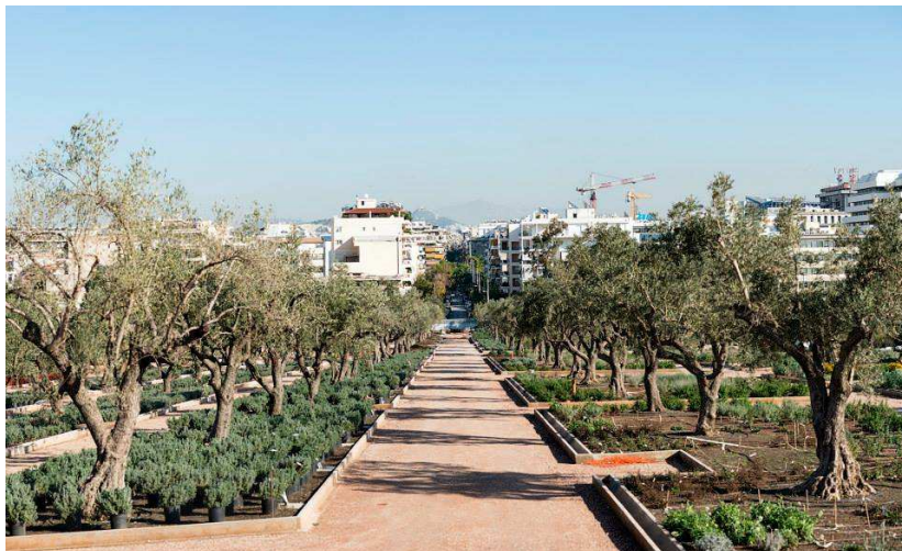
Διάδρομοι από σταθεροποιημένο χώμα
