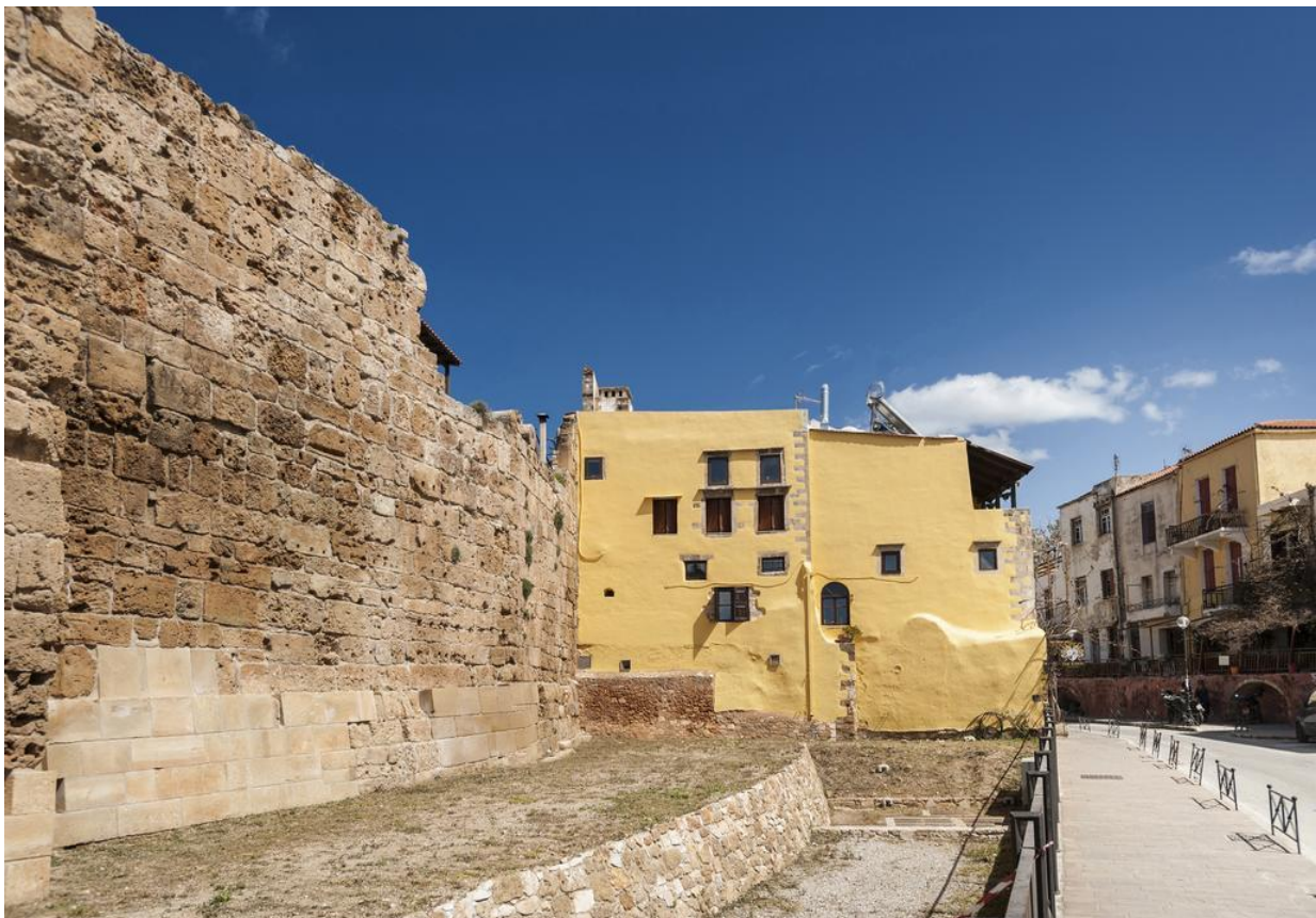
Οδός Σήφακα υφιστάμενη κατάσταση
