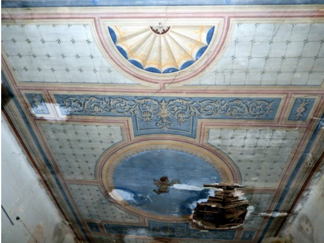
Εικόνα 6: Τμήμα των οροφογραφιών στον Α' όροφο
