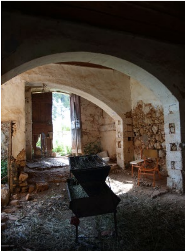
Εικόνα 4: . Μερική άποψη των ισόγειων βοηθητικών χώρων
