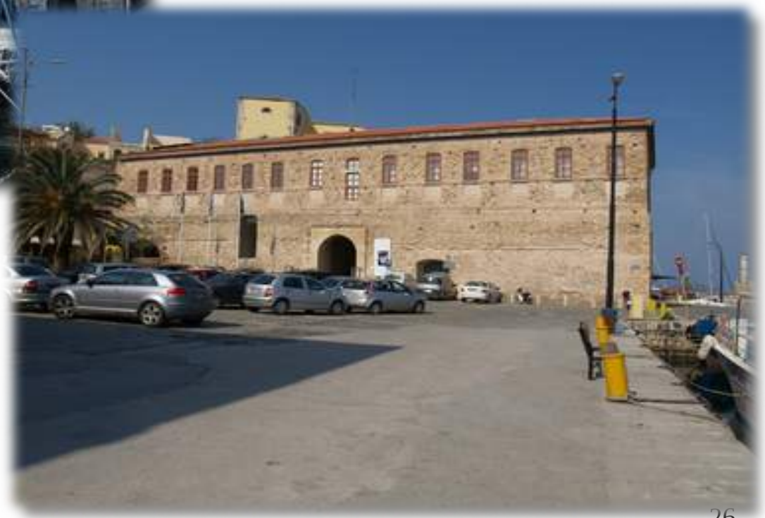
ΑΠΟΚΑΤΑΣΤΑΣΗ – ΕΠΑΝΑΧΡΗΣΗ ΜΕΓΑΛΟΥ ΑΡΣΕΝΑΛΙΟΥ ΓΙΑ ΤΗ ΣΤΕΓΑΣΗ ΤΟΥ ΚΕΝΤΡΟΥ ΑΡΧΙΤΕΚΤΟΝΙΚΗΣ ΜΕΣΟΓΕΙΟΥ (Κ.Α.Μ.)
