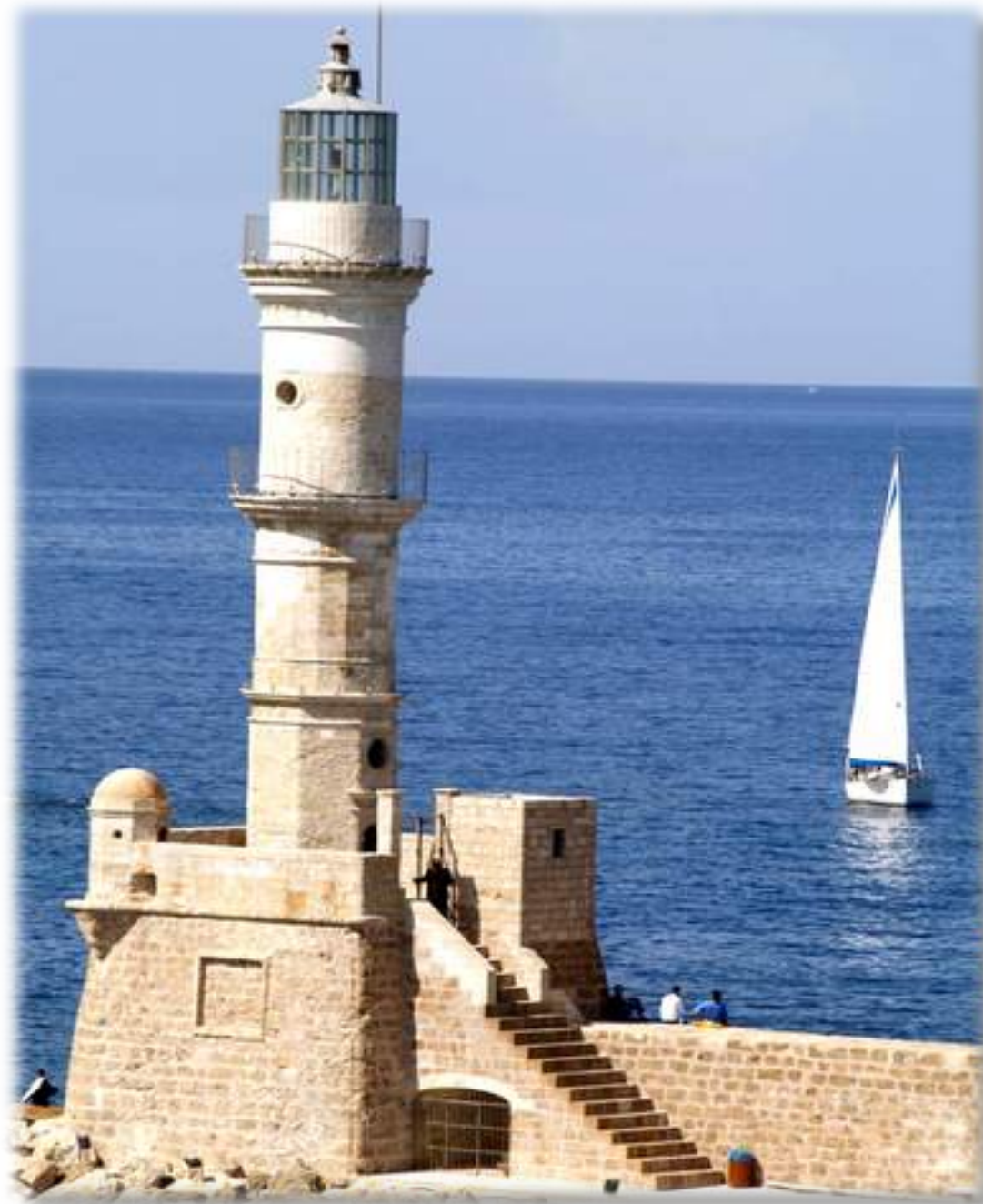
ΑΠΟΚΑΤΑΣΤΑΣΗ ΚΑΙ ΑΝΑΔΕΙΞΗ ΦΑΡΟΥ ΚΑΙ ΔΥΤΙΚΟΥ ΤΜΗΜΑΤΟΣ ΛΙΜΕΝΟΒΡΑΧΙΟΝΑ ΕΝΕΤΙΚΟΥ ΛΙΜΕΝΑ ΧΑΝΙΩΝ
