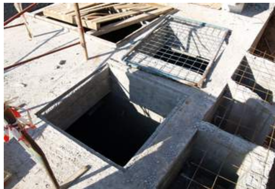
ΚΑΤΑΣΚΕΥΗ ΑΥΤΟΝΟΜΟΥ ΔΙΚΤΥΟΥ ΠΥΡΟΣΒΕΣΗΣ ΚΑΙ ΠΛΑΚΟΣΤΡΩΣΗ ΟΔΩΝ ΕΠΕΜΒΑΣΗΣ ΣΤΗ ΣΠΛΑΝΤΖΙΑ
