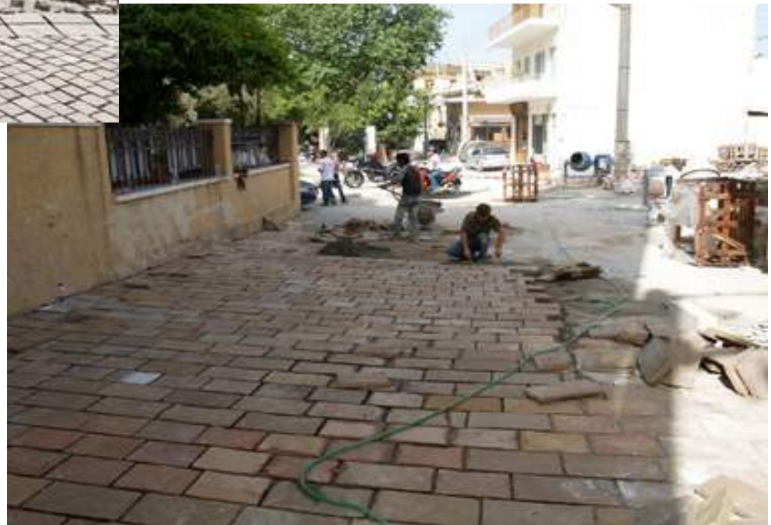
ΑΝΑΠΛΑΣΗ ΟΔΩΝ ΚΑΙ ΚΟΙΝΟΧΡΗΣΤΩΝ ΧΩΡΩΝ ΠΕΡΙΞ Ι. Ν. ΑΓΙΟΥ ΝΙΚΟΛΑΟΥ & ΠΛΑΚΟΣΤΡΩΣΗ ΠΛΑΤΕΙΑΣ ΣΠΛΑΝΤΖΙΑΣ
