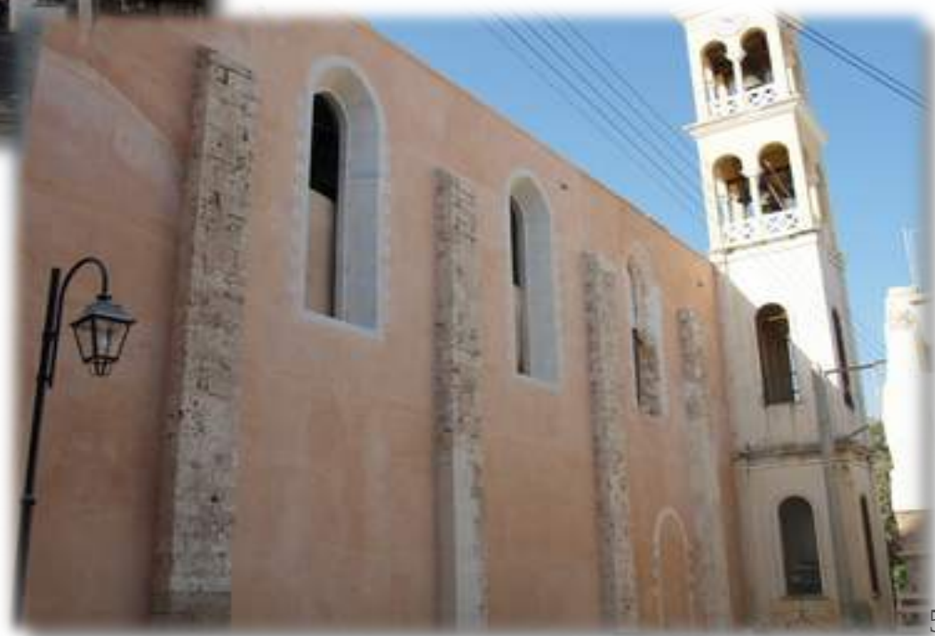
ΑΠΟΚΑΤΑΣΤΑΣΗ ΟΨΕΩΝ Ι. Ν. ΑΓΙΟΥ ΝΙΚΟΛΑΟΥ
