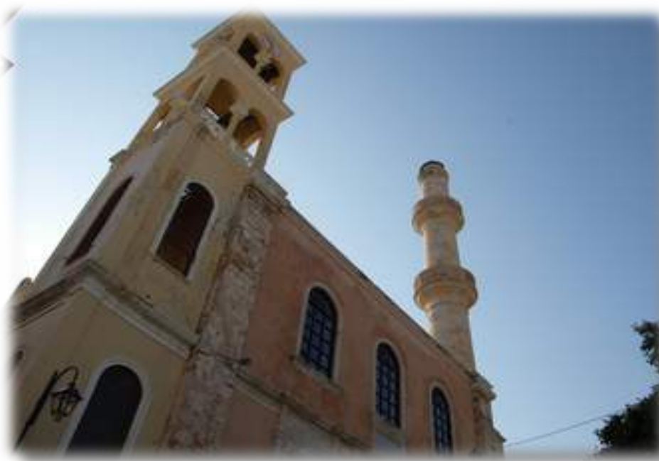
ΑΠΟΚΑΤΑΣΤΑΣΗ ΟΨΕΩΝ Ι. Ν. ΑΓΙΟΥ ΝΙΚΟΛΑΟΥ
