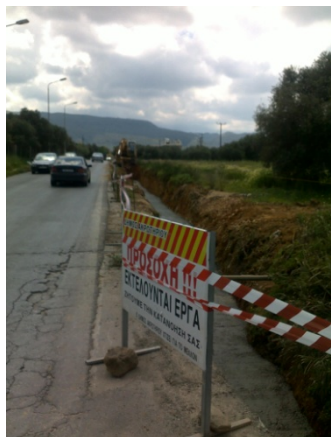
Νέα αποχετευτικά έργα
