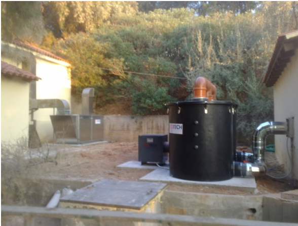
Εγκατάσταση Απόσμησης στο κεντρικό Αντλιοστάσιο (Α3) λυμάτων Χανίων
