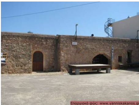
Περιτοίχιση και πλακόστρωση πλατείας Καθιανών
