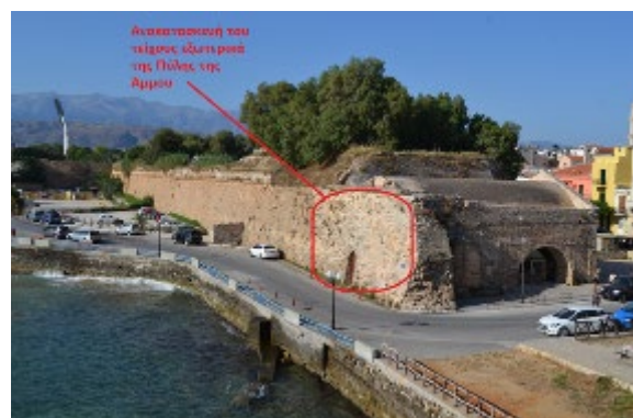
Εικόνα 6 : Ανακατασκευή τμήματος του τείχους από τους Τούρκους, εξωτερικά της Πύλης της Άμμου.
