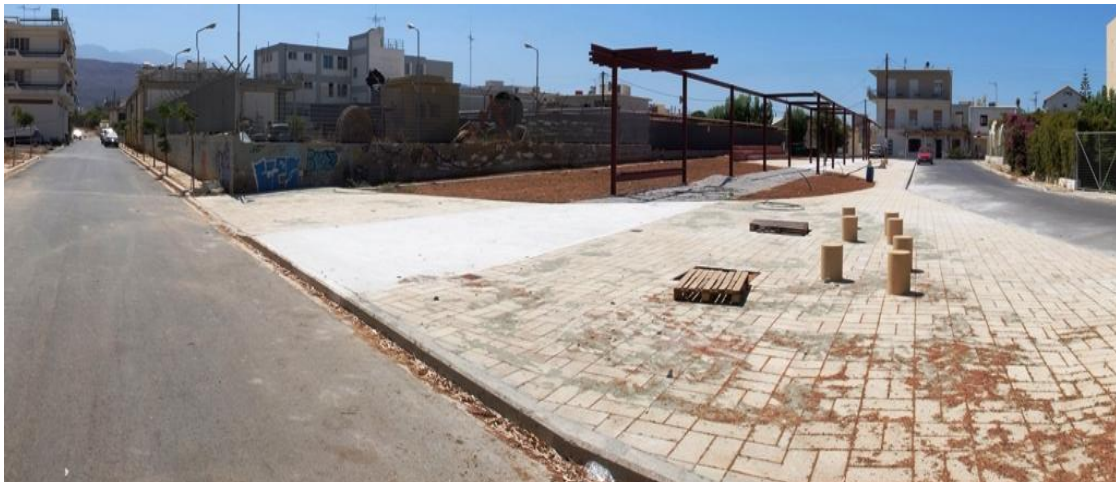
Διανοίξεις Γρ. ΔΕΗ και Πάρκο (2009-10)
