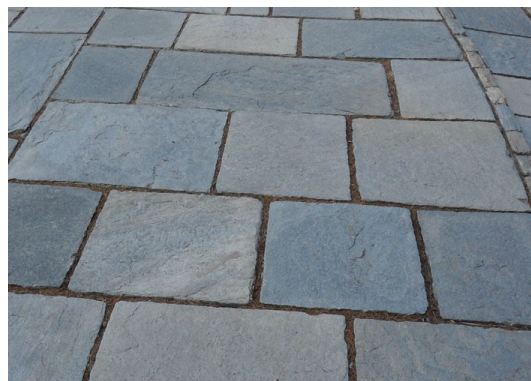
Δάπεδο με πέτρα Καβάλας γωνιασμένες δια
