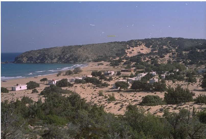
Αυθαίρετη δόμηση στον οικισμό Σαρακήνικο
