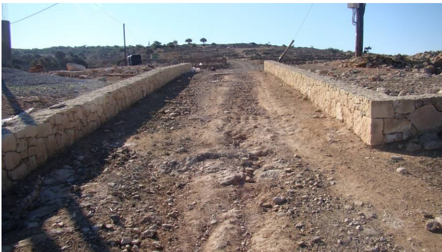
Νέοι τοίχοι από αργολιθοδομή
