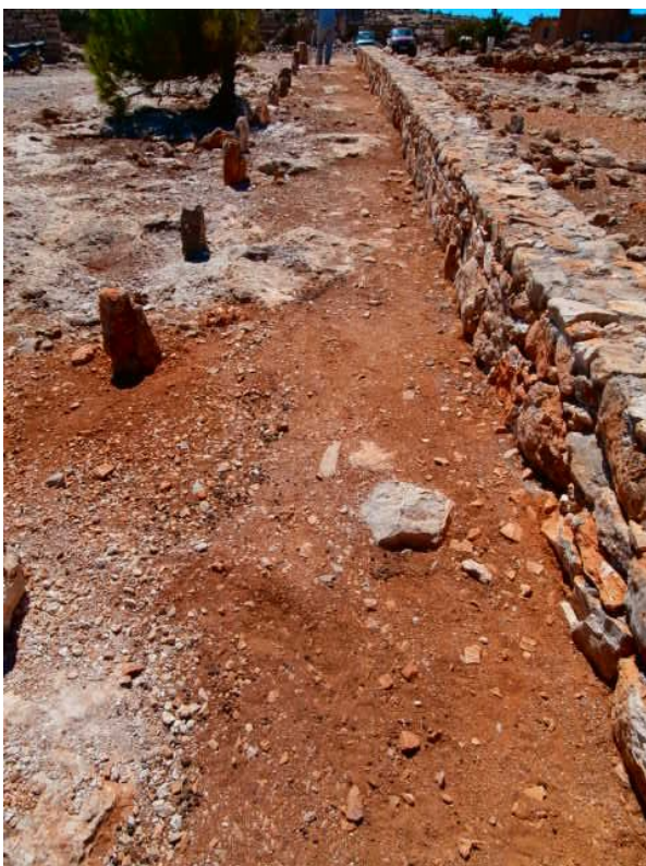
Τοποθέτηση φυτεμένων λίθων για την οριοθέτηση μονοπατιού
