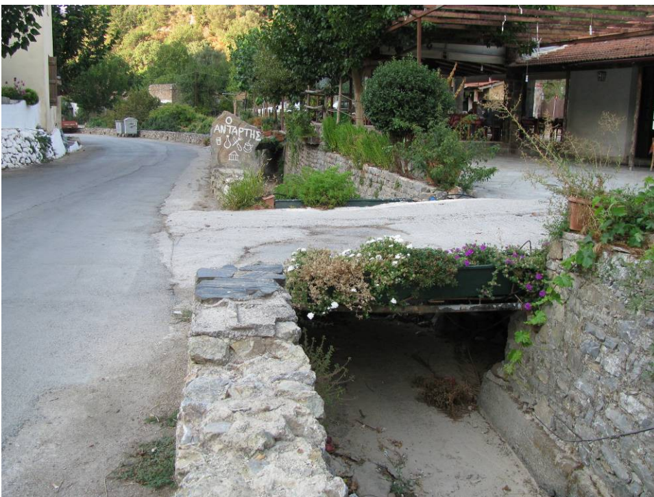
Εικόνα 18: Γεφυράκι από τσιμέντο ( θέση λήψης 14)
