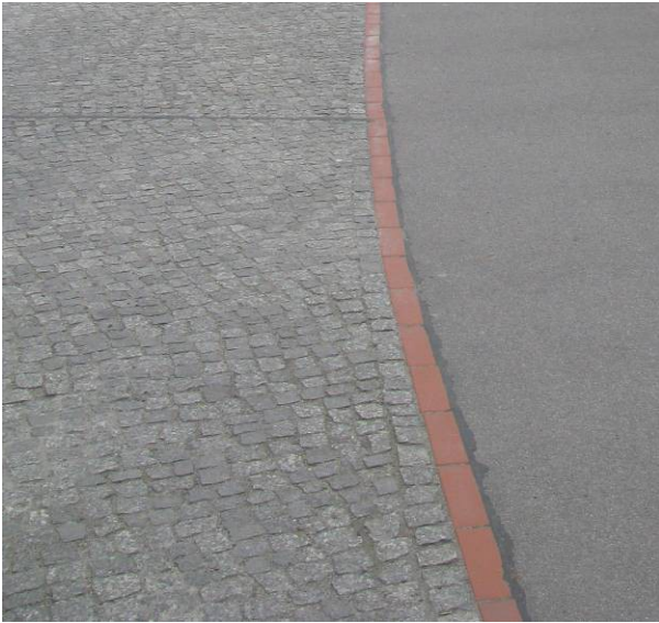
Εικόνα 36 Διαχωριστικές λωρίδες από τούβλο
