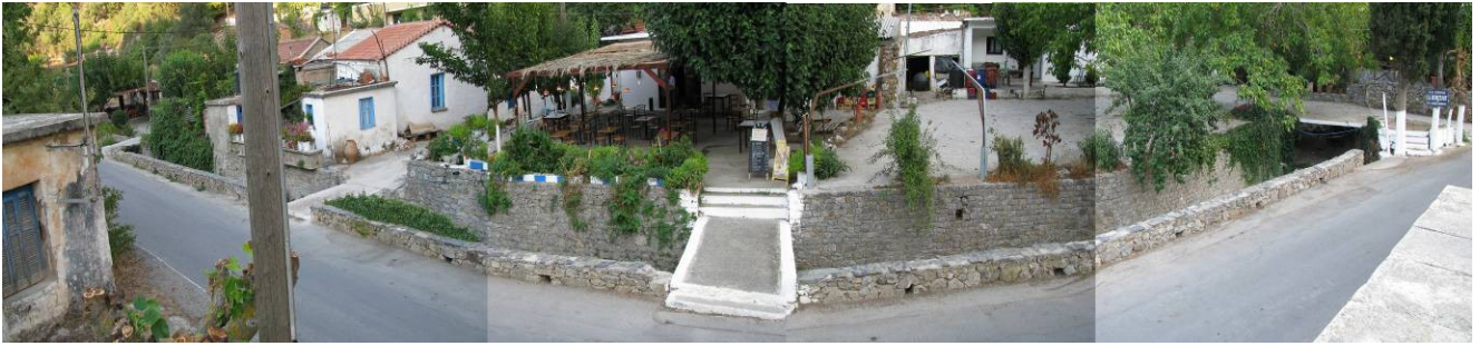
Εικόνα 5: Ο κεντρικός δρόμος και το ρέμα (θέση λήψης 01)
