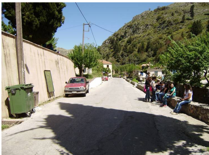
Εικόνα 12: Ο κεντρικός δρόμος με το προστατευτικό τοίχιο του ρέματος (θέση λήψης 08)
