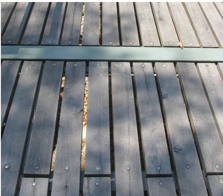
Εικόνα 37 Ξύλινο εξωτερικό δάπεδο από καρφωτές σανίδες ξύλου ιρόκο
