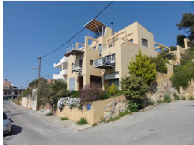
Φωτογραφία Α.4.6.3.β.: Κατοικίες σύγχρονης αρχιτεκτονικής στον Προφήτη Ηλία
