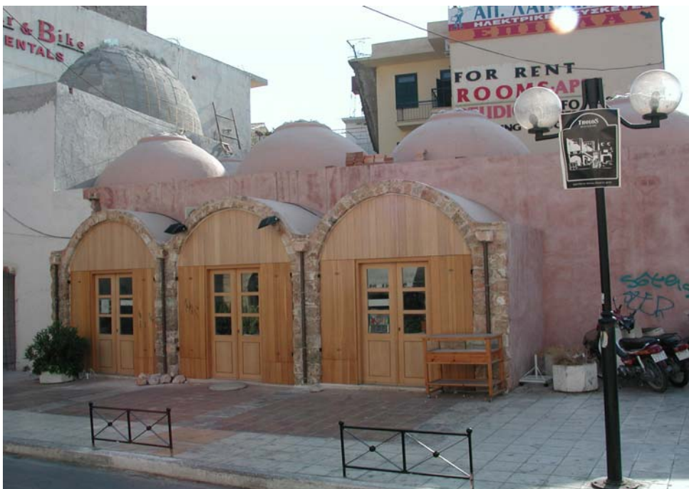
φωτ. 8 – Χαμάμ οδού Χάληδων
