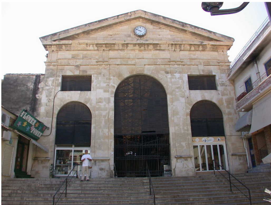
Εικ. 27: Η βόρεια όψη της αγοράς, όπου διακρίνονται οι πολυπληθείς συμπληρώσεις μάρτυρες για την έκταση των φθορών.
