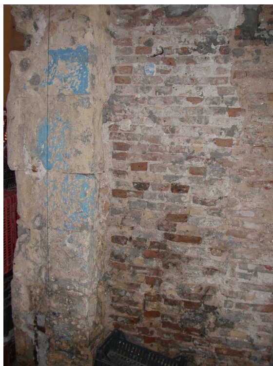
Εικ. 24: Εσωτερικό υποστύλωμα από ημιλαξευτή λιθοδομή και διαχωριστική τοιχοποιία από οπτοπλινθοδομή.
