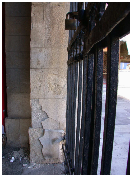
Εικ. 28,29: Φαίνεται ότι η βόρεια όψη (όπως και η νότια) είναι κατασκευασμένη, σε ολόκληρο το πάχος της, από λαξευτή λιθοδομή.
