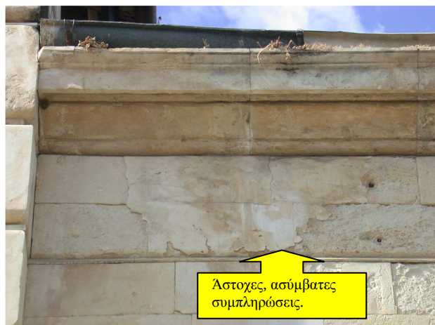
Εικ. 7, 8: Λεπτομέρειες από τη φθορά των λίθων και την αστοχία των επισκευών σε λίθους της νότιας όψης, λόγω της είσδυσης των ομβρίων.
