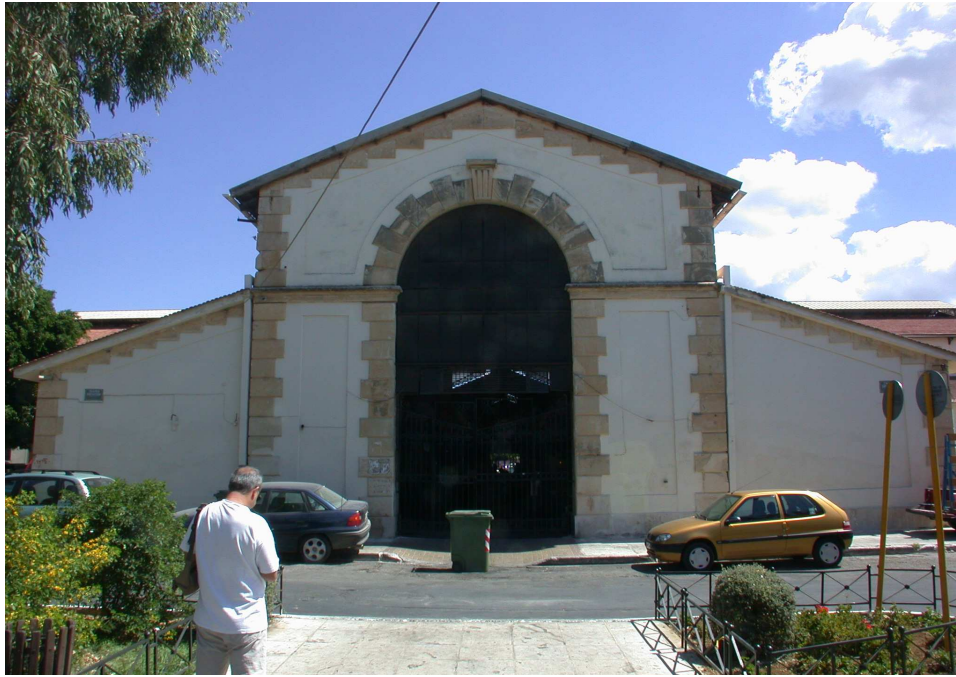
Εικ. 9: Δυτική όψη, η χρήση εμφανούς λιθοδομής περιορίζεται στα θυρώματα, στις παραστάδες και στις γωνίες.
