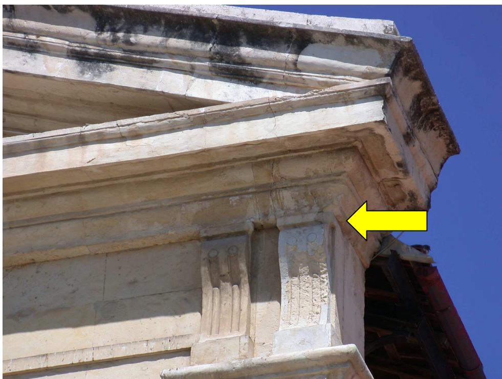
Εικ. 3: Νότια όψη, τα προβλήματα στη Ν.Α. γωνία του θριγκού από τα όμβρια που κατεισδύουν.
