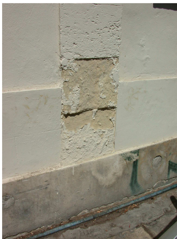
Εικ. 18: Ο ρόλος της ανερχόμενης υγρασίας.
