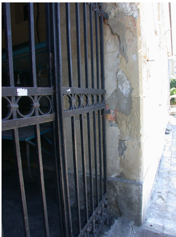
Εικ. 21,22: Δυτική πύλη, για την κατασκευή των πεσσών έχουν χρησιμοποιηθεί λαξευτοί λίθοι..
