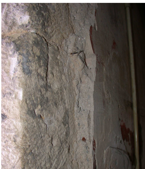
Εικ. 25: Το επίχρυσμα της αργολιθοδομής σε δύο στρώματα.
