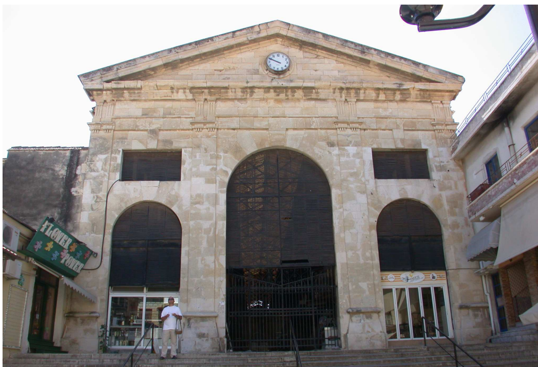
Εικ. 2: Η βόρεια όψη κατασκευασμένη και αυτή από εμφανή, λαξευτή λιθοδομή παρουσιάζει εκτεταμένες βλάβες λόγω της προχωρημένης φθοράς και των πολυάριθμων αστοχιών των λίθων.
