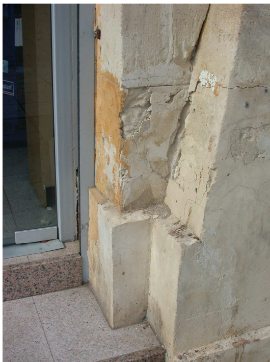
Εικ. 5, 6: Λεπτομέρειες από τη φθορά των λίθων στα κατώτερα τμήματα της νότιας όψης λόγω της αναρρίχησης της εδαφικής υγρασίας. Κακότεχνες συμπληρώσεις με κονίαμα και άστοχη αφαίρεση graffiti.
