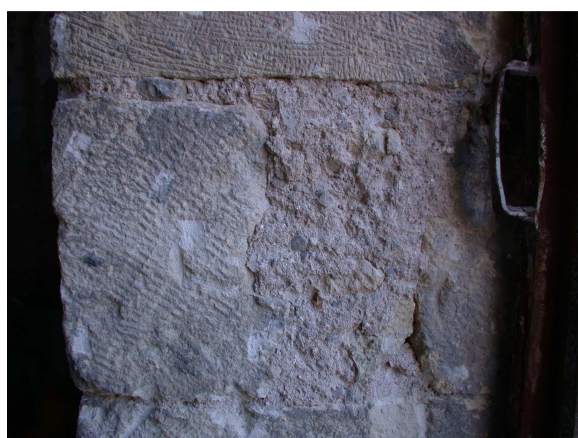
Εικ. 24: Εσωτερικό υποστύλωμα από ημιλαξευτή λιθοδομή και διαχωριστική τοιχοποιία από οπτοπλινθοδομή.
