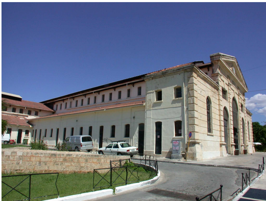
Εικ. 16: Άποψη του κτηρίου από τα Ν.Δ.
