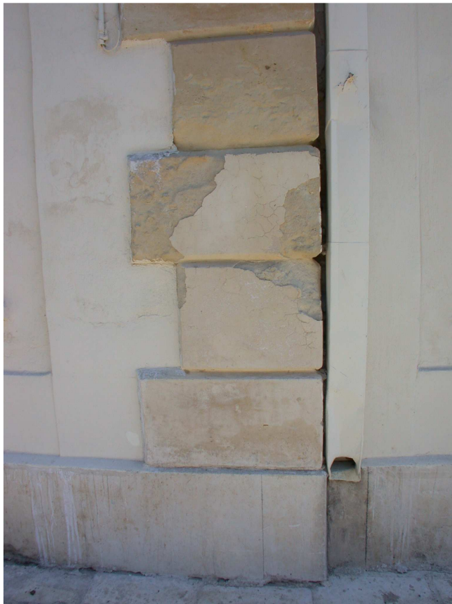
Εικ. 9: Δυτική όψη, η χρήση εμφανούς λιθοδομής περιορίζεται στα θυρώματα, στις παραστάδες και στις γωνίες.
