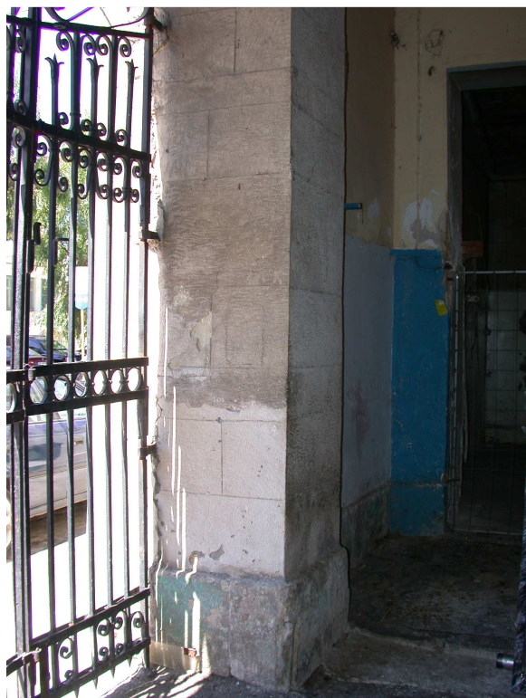
Εικ. 21,22: Δυτική πύλη, για την κατασκευή των πεσσών έχουν χρησιμοποιηθεί λαξευτοί λίθοι..
