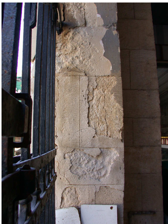
Εικ. 28,29: Φαίνεται ότι η βόρεια όψη (όπως και η νότια) είναι κατασκευασμένη, σε ολόκληρο το πάχος της, από λαξευτή λιθοδομή.
