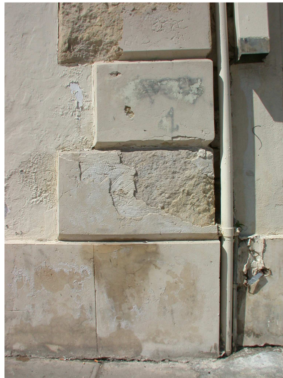
Εικ. 13: Η φθορά στους μαργαϊκούς λίθους και τις συμπληρώσεις από τη μεταφορά και απόθεση των διαλυτών αλάτων.
