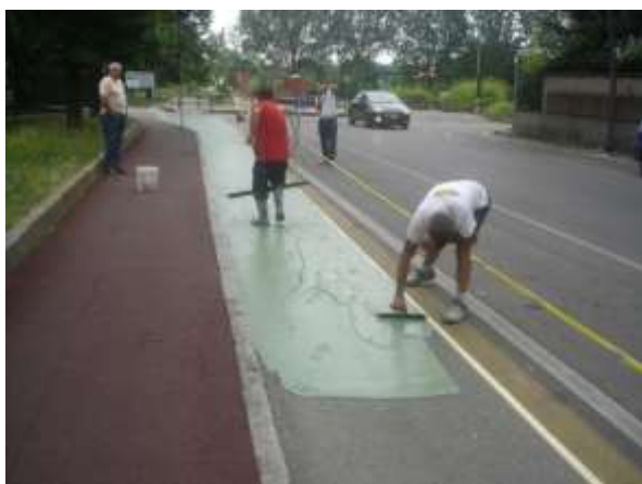
Εικ. 2 Φωτοκαταλυτική επίστρωση ποδηλατοδρόμου σε επιφάνεια ασφάλτου
