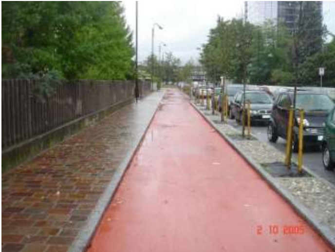
Φωτοκαταλυτική επίστρωση ποδηλατοδρόμου σε βάση με τσιμεντοειδή επίστρωση.
