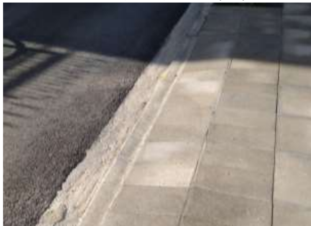
Διαμόρφωση ράμπας εισόδου οχήματος σε ιδιωτικό χώρο στάθμευσης με πλακόστρωση
