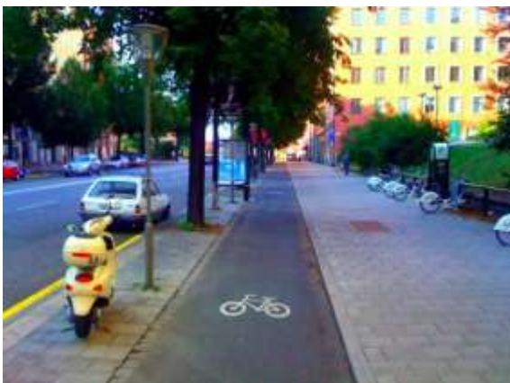
Χαρακτηριστική εικόνα ποδηλατοδρόμου επί πεζοδρομίου με λωρίδα διαχωρισμού
