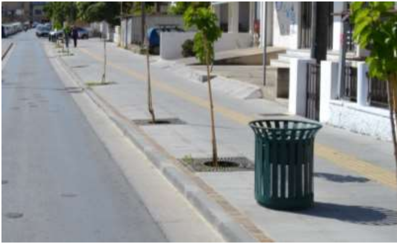
Νέο πεζοδρόμιο με γκρι τσιμεντόπλακες και λεπτομέρεια από πέτρινο κυβόλιθο (οδός Πειραιώς)
