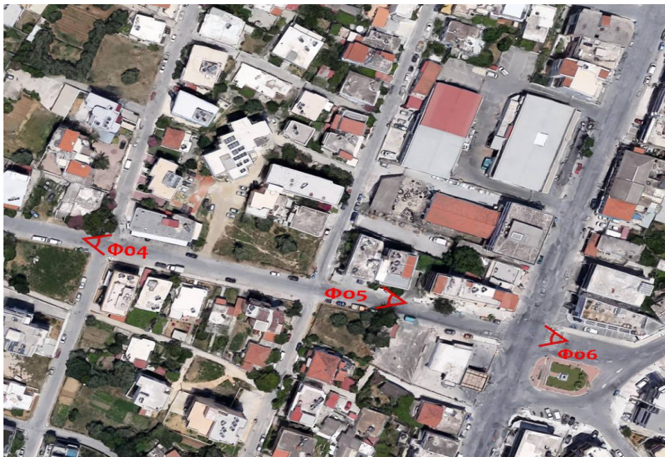
Εικόνα 4: Αεροφωτογραφία τμήματος με θέσεις λήψεως φωτογραφιών.
