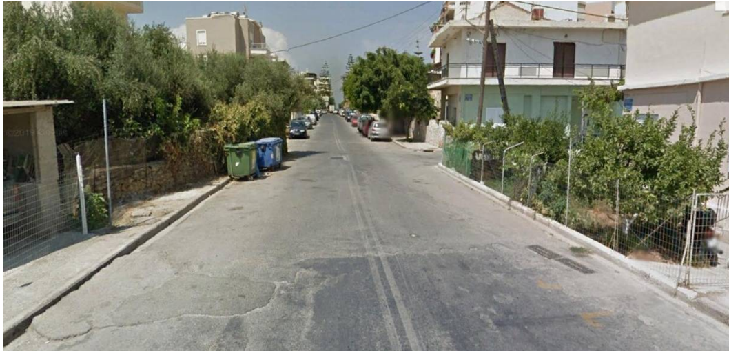
Εικόνα 5: Υφιστάμενη κατάσταση της οδού Μονής Γωνιάς, όπου παρατηρείται η έλλειψη πεζοδρομίων (δεξιά) και η ανεπάρκεια πρόσβασης (αριστερά).
