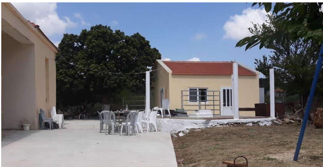
Βοηθητικό κτίσμα και στέρνα
