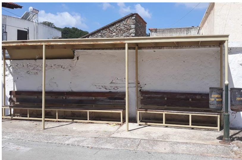
Λαμαρινοσκεπής Στάση λεωφορείου
