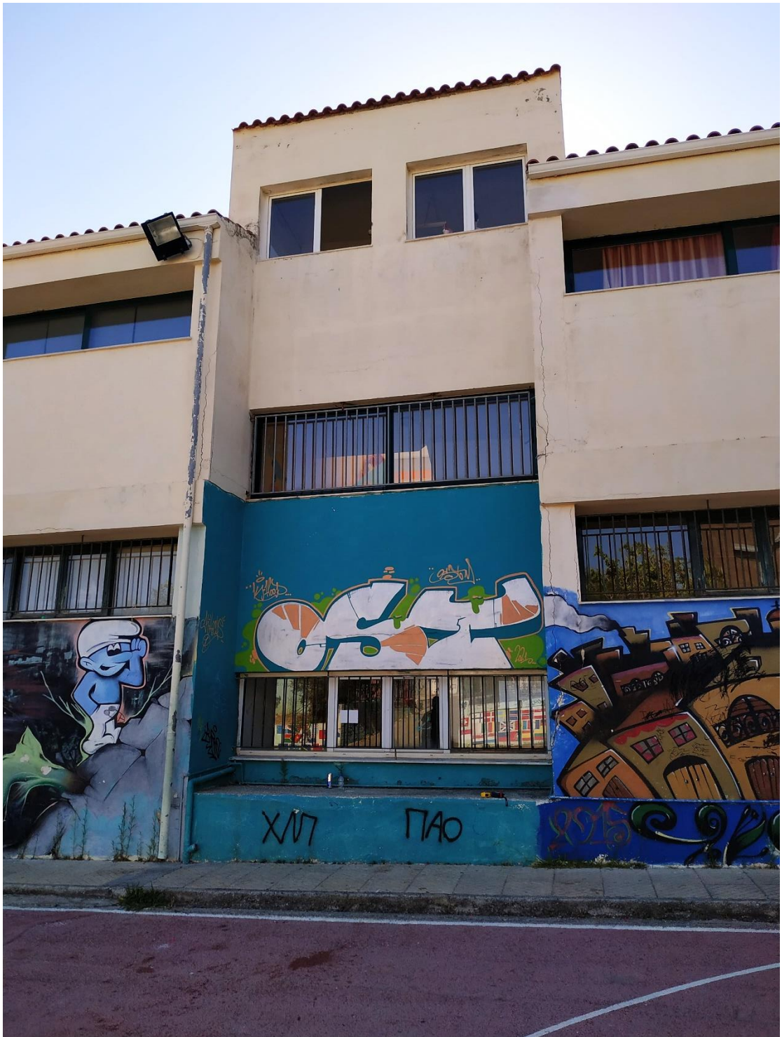
Εικόνα 2. Εξωτερικό όψη κτιρίου (δυτική).
