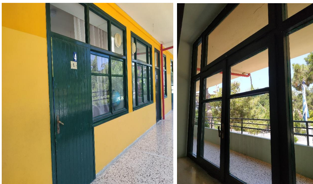
Εικόνα 4. Ξύλινα κουφώματα με μονούς υαλοπίνακες.
