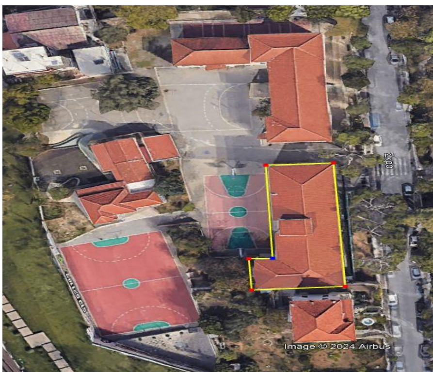
Εικόνα 1. Διώροφο κτίριο 9 ου δημοτικού σχολείου Χανίων.
