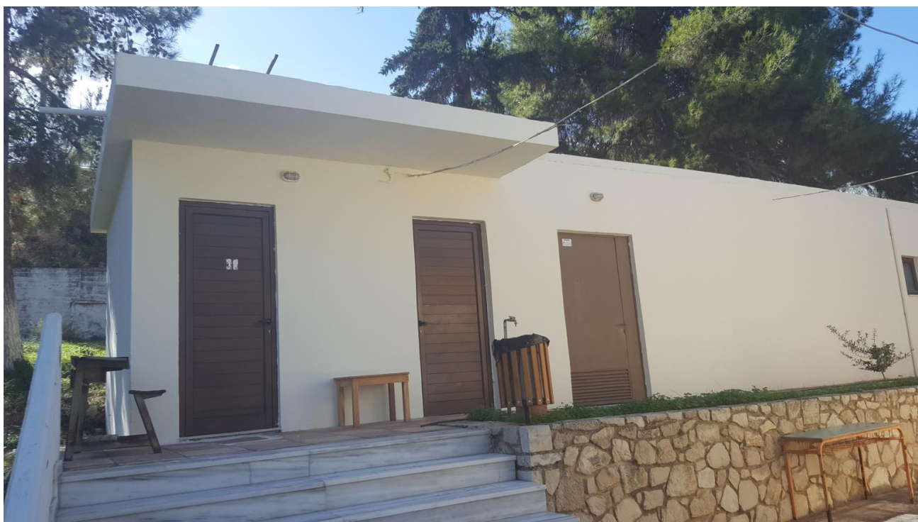
Εικ.11 Βόρεια πλευρά κτιρίου 5 –WC Εφάπτεται με κτίριο 4 Αποθήκη
